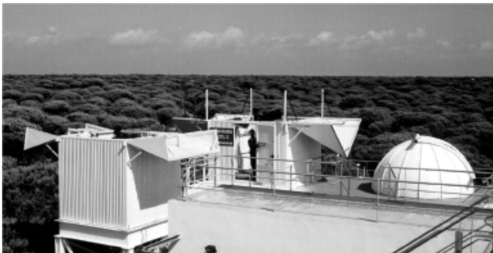
obr. 1 Stanice BOOTES-1 obsahuje dva domečky označované A a B. Střechy systému jsou automaticky ovládány meteorologickou stanicí. Její sonda je vpravo vpředu.
